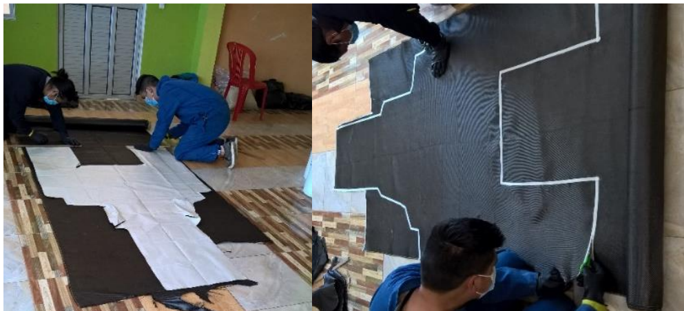
Figura 79-3: Preparación de cortes y Corte de la Fibra
