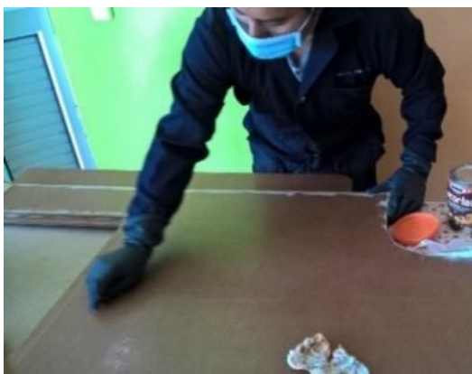
Figura 77-3: Aplicación de Desmoldante
