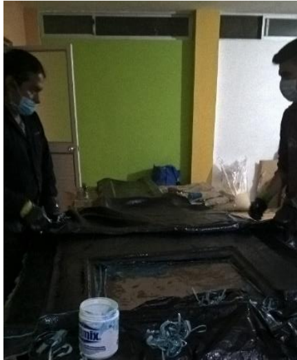
Figura 82-3: Colocacion de la Fibra
