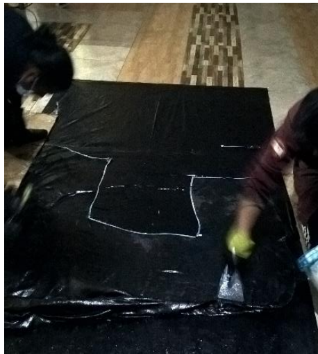
Figura 81-3: Saturación de la Fibra de Carbono
