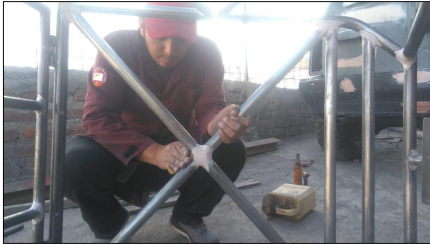
Gráfico 71-4: Remoción del exceso de material de la masilla. Realizado por: Los autores
