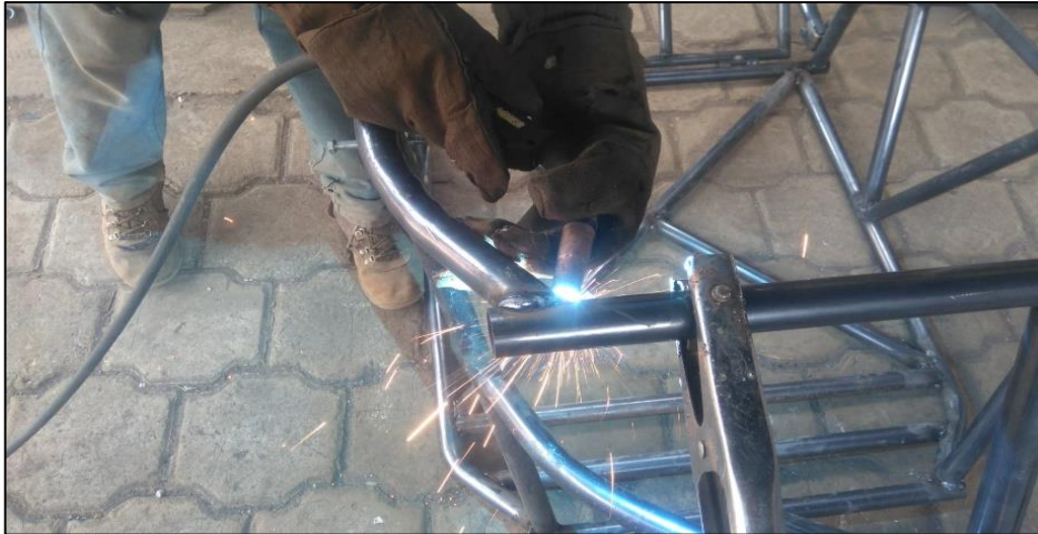
Gráfico 51-4: Ensamblaje de la base mediante soldadura por arco en protección gaseosa Realizado por: Los autores
