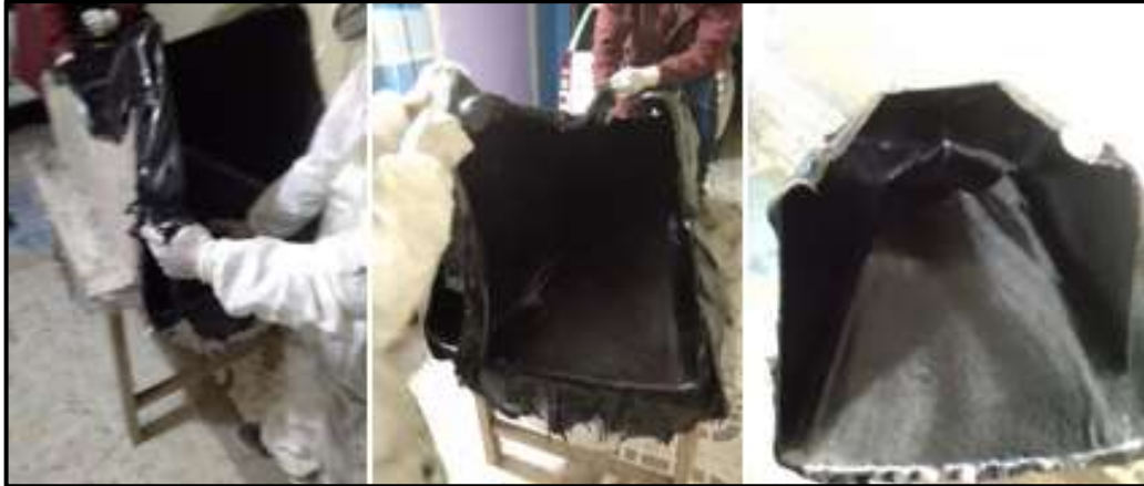
Figura 86-3: Aplicación de la 1er, 2da y 3era cada de fibra de carbono y resina epoxi Fuente: Autores
