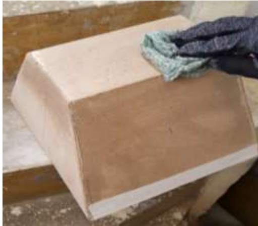
Figura 79-3: Aplicación cera desmoldante Fuente: Autores
