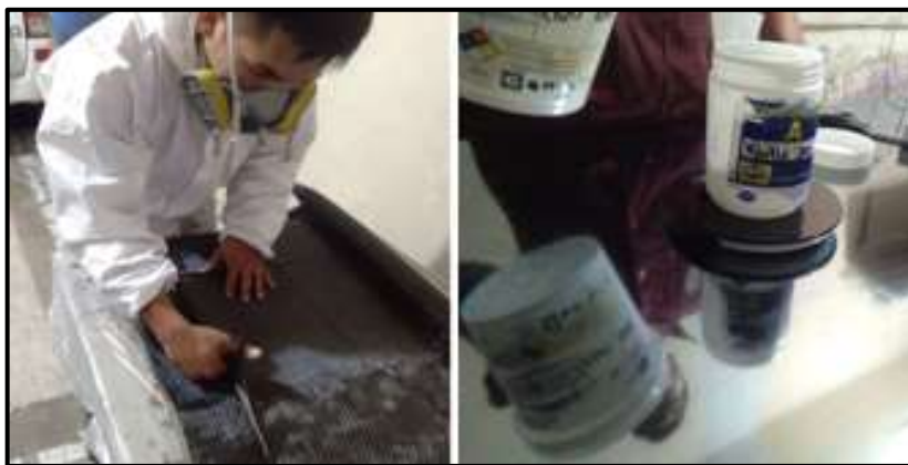
Figura 83-3: Corte de la fibra de carbono y preparación de la resina Fuente: Autores
