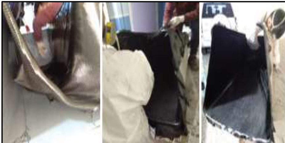
Figura 85-3: Aplicación de la primera capa de material compuesto Fuente: Autores
