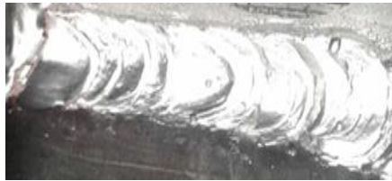
Figura 6-3: Cordón de la junta soldada E02.2 Realizado por: Autores, 2018
