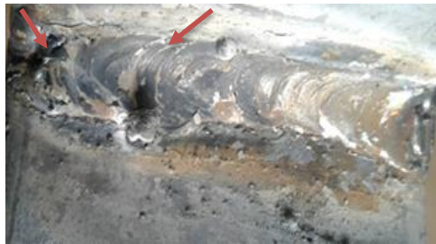
Figura 3-3: Porosidad en el cordón de soldadura E01.1
