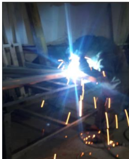
Figura 7-2: Aplicación de la soldadura GMAW Fuente: Autores, 2018
