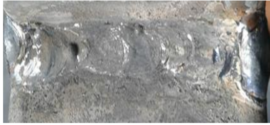
Figura 8-3: Cordón irregular de la junta soldada E03.2 Realizado por: Autores, 2018
