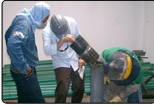
Figura 38-1: Inspección de Soldadura
