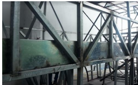
Figura 29-1: Soldadura en perfiles rectangulares Fuente: Autores, 2018
