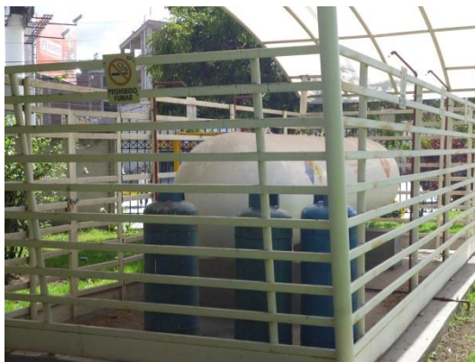
Ilustración 6 Gas centralizado
