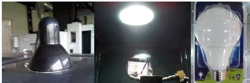
Figura 22-3: Sistema de iluminación
