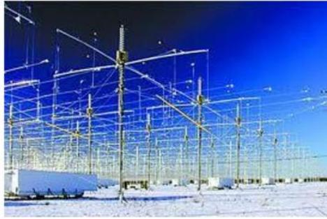
**Figura 19-2.** Array de antenas de hilo
