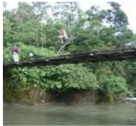
Puente la unión
