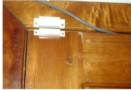
Figura V.79 Ubicación del sensor Magnético
