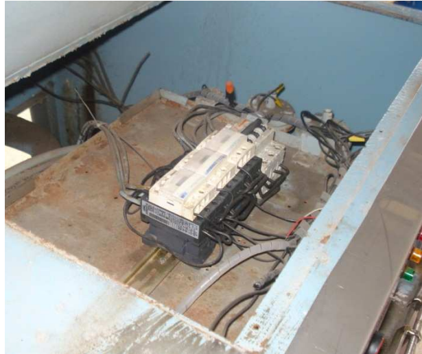
Figura V.2 Reemplazo de contactores
