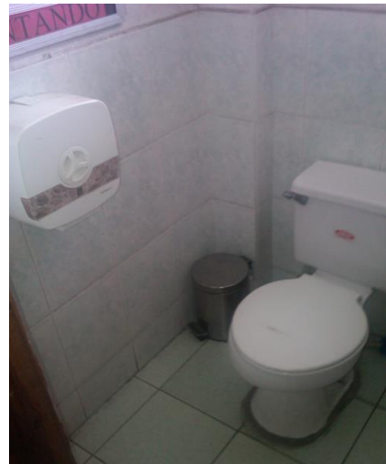
sanitarios del personal
