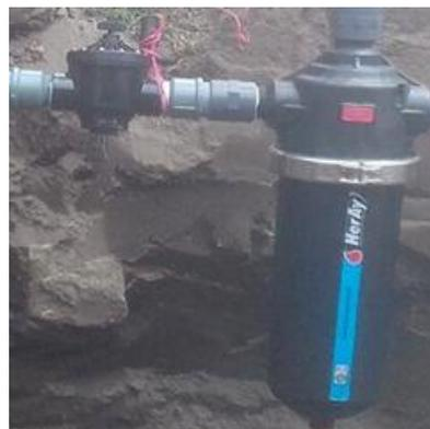
**Figura 57 -4:** Acoples en válvula 1 y entrada de filtro.
