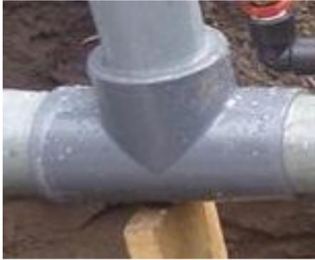
**Figura 53-4:** Tee de PVC con reductor de 63mm.
