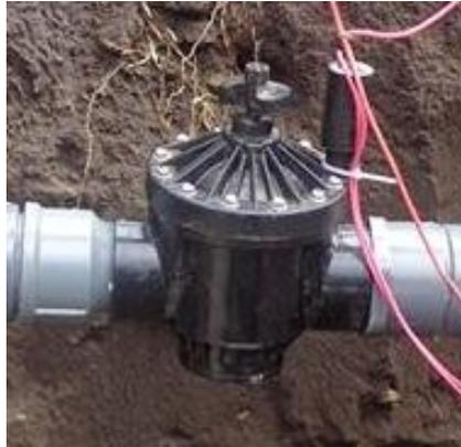
**Figura 56-4:** Adaptador de 63mm con reductor de 2"
