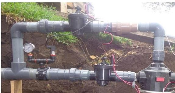
**Figura 59-4:** Unión de sección de secundaria.
