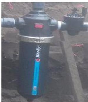
**Figura 58-4:** Acople de salida de filtro a electroválvula 2.
