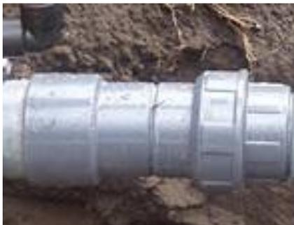
**Figura 55-4:** Adaptador de 75mm con reductor 63mm.
