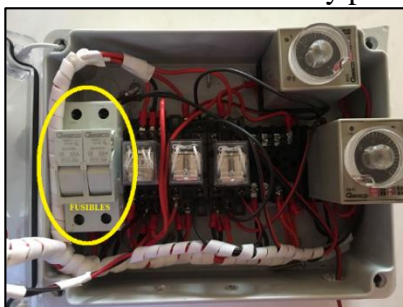
Figura 13-5. Ubicación fusibles y portafusibles
