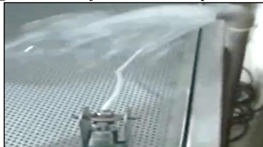
Figura 21-5. Flujo de la salmuera por la tubería.
