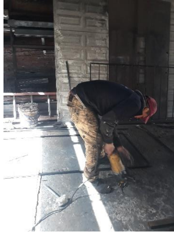
Figura 1-4. Área de pre-acabado
