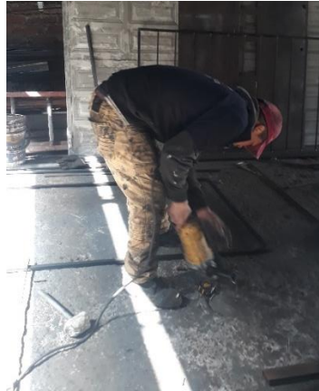
Figura 11-3. Área de pre-acabado
