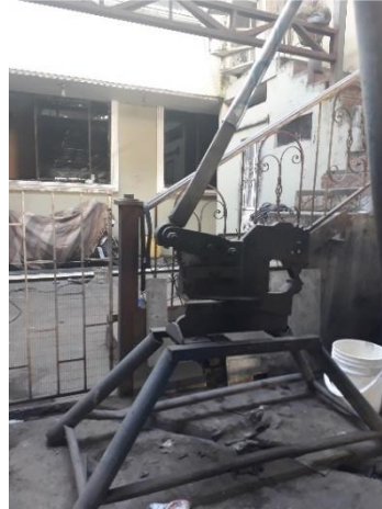
Figura 7-3. Corte de paneles
