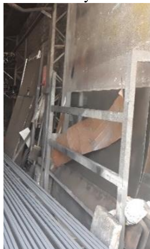
Figura 6-3. Medición y trazado de paneles
