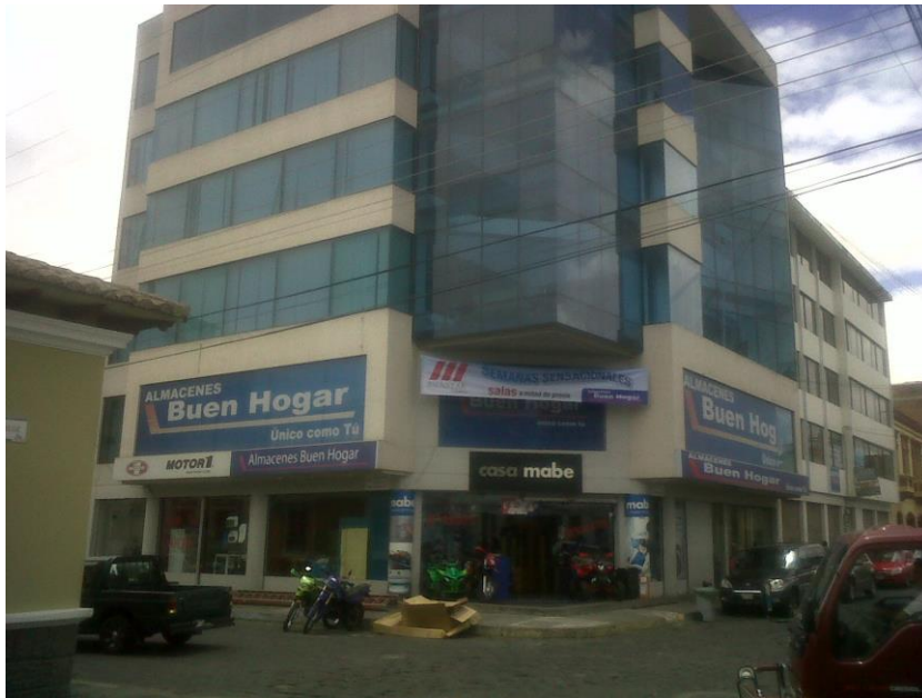
Fotografía N° 1: Almacén Buen Hogar
