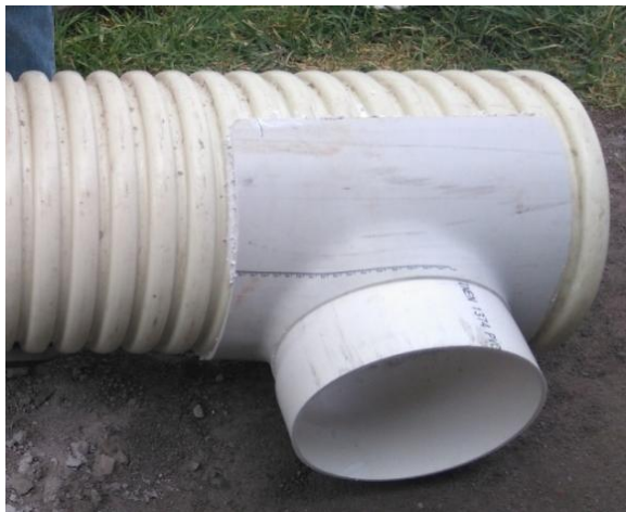
Figura 4-23. Construcción del accesorio tipo T
