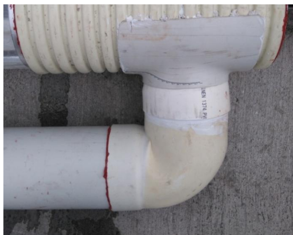
Figura 4-5. Unión codo y tubo inferior
