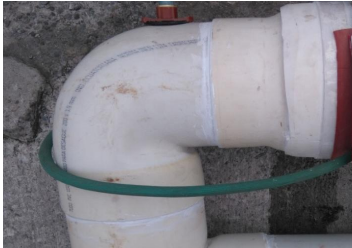
Figura 4-8. Unión codo tres y reducción
