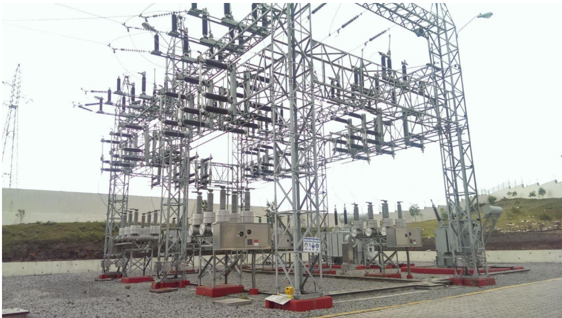
Figura 8-2. Transformador de Corriente
