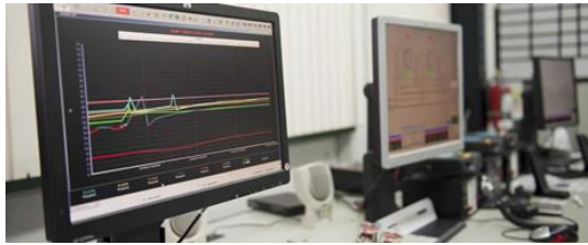
Figura 24-1: Centro de control principal del oleoducto
