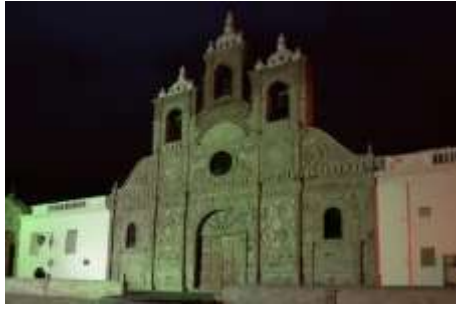
Figura 8-1: Iglesia de la Catedral en Riobamba
