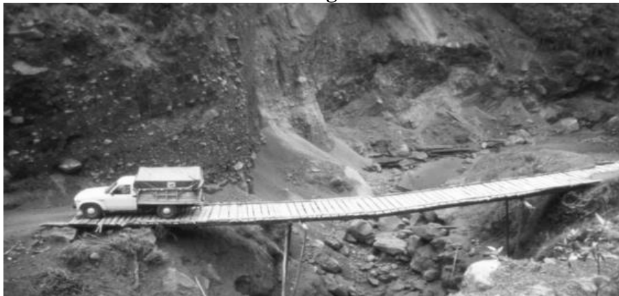
Gráfico 3: Puente de madera construido por los habitantes del flanco oeste del volcán Tungurahua
