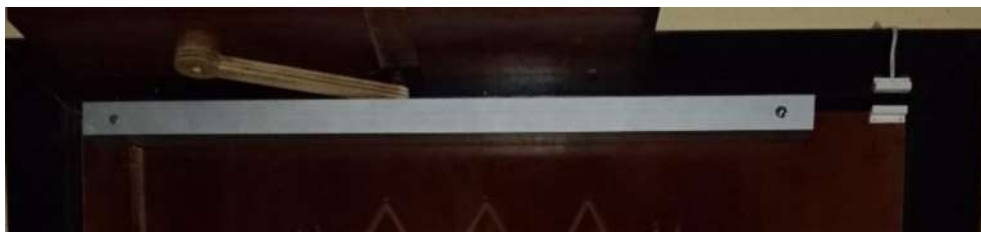
Figura 30-2: Sensor magnético colocado en la puerta Realizado por: Sebastián Cuenca; Alex Manotoa; 2017.
