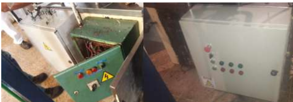
Figura 26-2 Tableros antiguos vs tablero nuevo instalado
