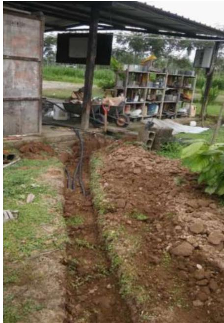
**Figura 23-2:** Instalación de la tubería en la zanja.
