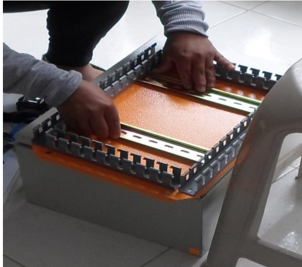
Figura 11 - 2 Distribución de Riel Din y canaletas Realizado por: VELASCO, Deicy, 2017
