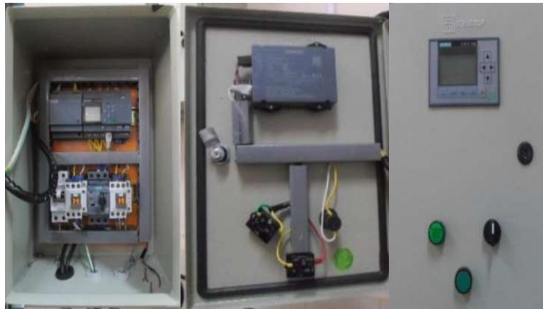
Figura 16 - 2 Vista interior y exterior del tablero terminado Realizado por: VELASCO, Deicy, 2017
