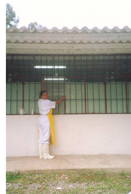
PROTECCION EN VENTANAS
