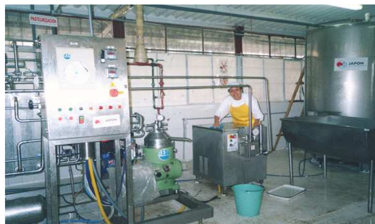
LIMPIEZA INTERNA DE EQUIPOS Y MAQUINARIA DE LA PLANTA
