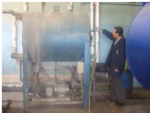
Figura. 5.11 Apertura de la llave de agua del tanque ablandador
