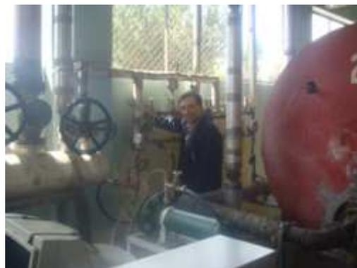
**Figura. 5.13** Apertura del paso de vapor al intercambiador
