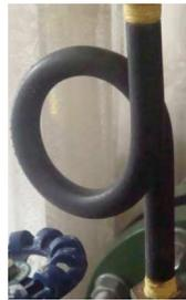
Figura. 5.3 Junta de expansión (rabo de chancho)
