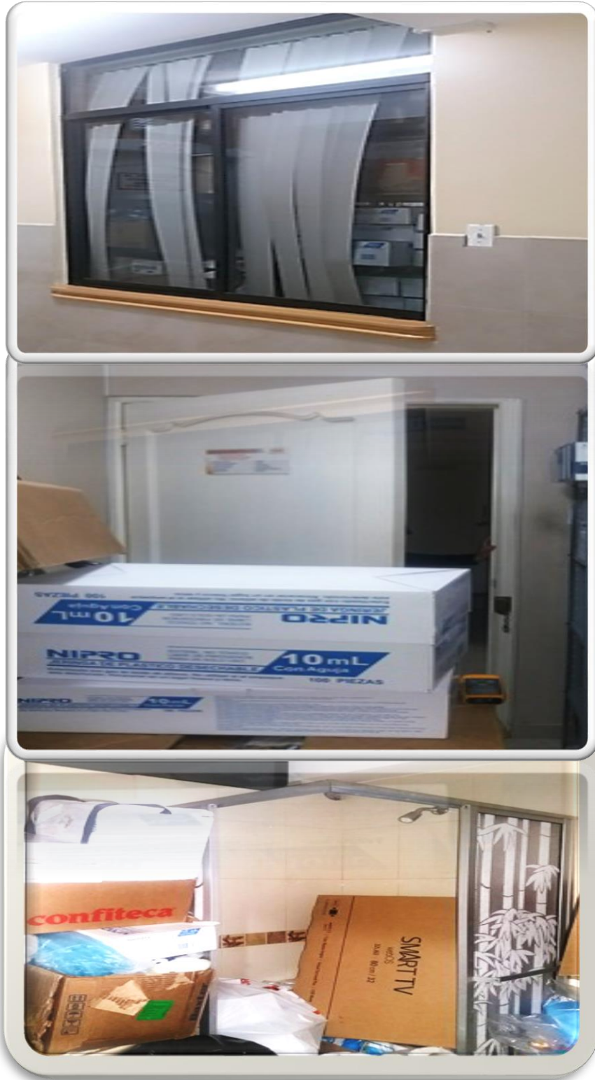
Figura 3-3: Ventanas grades y no localizadas a mayor altura, puerto con dificultad de acceso y dificultad de limpieza. Realizado por: Jennyfer Gavilanes I, 2018
