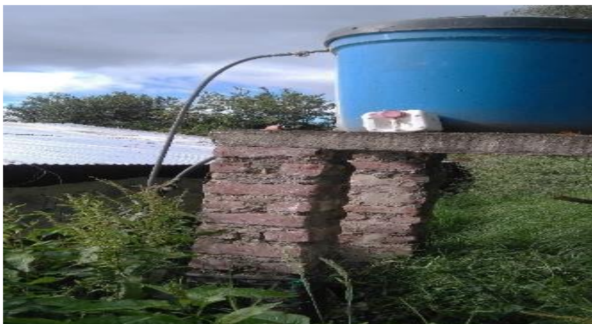
Fotografía 11. Reservorios de agua del galpón granja avícola "Dos Hermanos".
