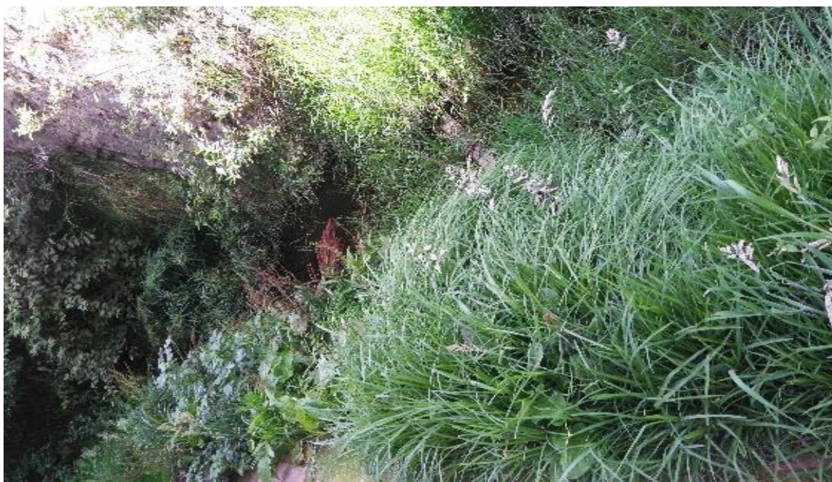
Fotografía 12. Drenaje y acumulación de aguas residuales granja avícola "Dos Hermanos".
