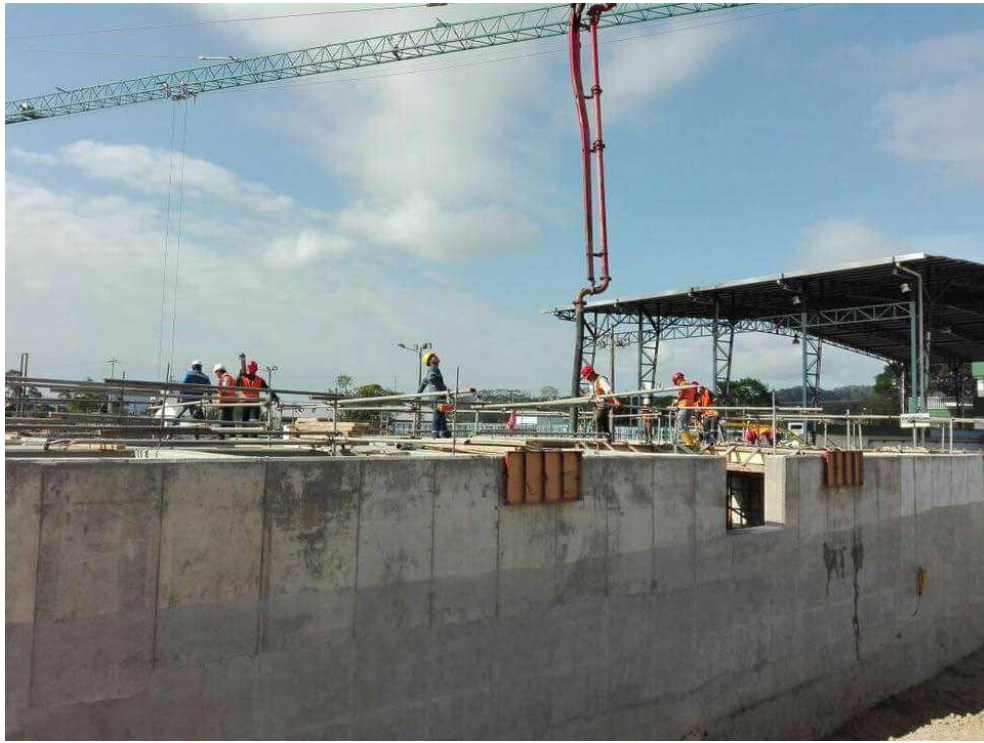
Anexo 11: Construcción de muro de contención para rivera de río Esmeraldas.
