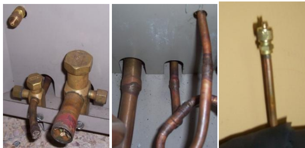
Figura 4.10 Detalles de la ubicación de la válvula de servicio y óbus.
