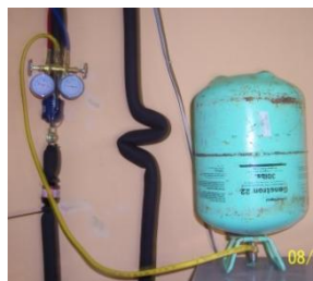
Figura 4.26 Carga de refrigerante al sistema de aire acondicionado, en estado gaseoso.
