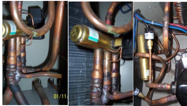
Figura 4.2 Detalles de la ubicación de la válvula de 4 Vías.
