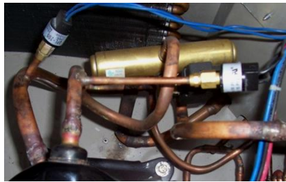
Figura 4.6 Detalles de la ubicación de swich de presión, alta y baja.
