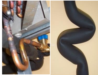
Figura 4.11 Detalles de la ubicación de Sifones.
