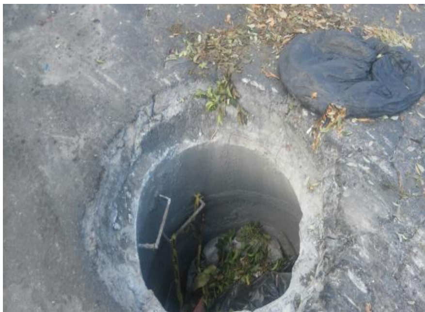
Figura 2-1 Alcantarilla sin la tapa correspondiente. Realizado por: Christian Córdova 2018
