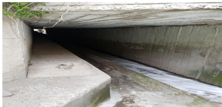
Figura 4-1 Canal de recolección previamente construido Fuente: Andrés Tacoamán
