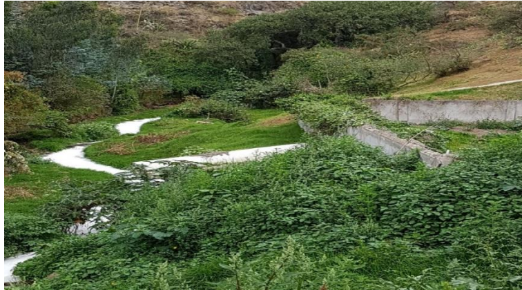
Figura 3-1 Tanque recolector colapsado Fuente: Andrés Tacoaman, 2017
