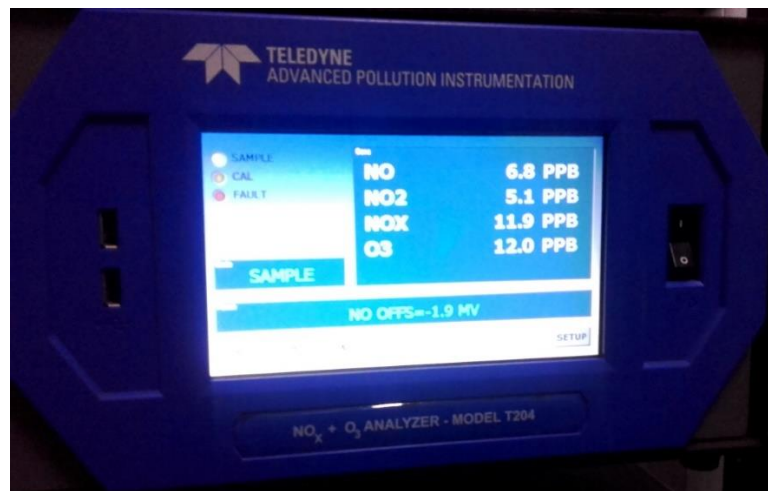
Figura 7-1 Datalogger de la estación de monitoreo Fuente: GAD
