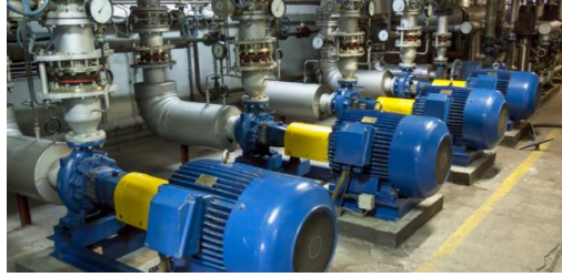
Figura 4-2. Instalación en back-up
