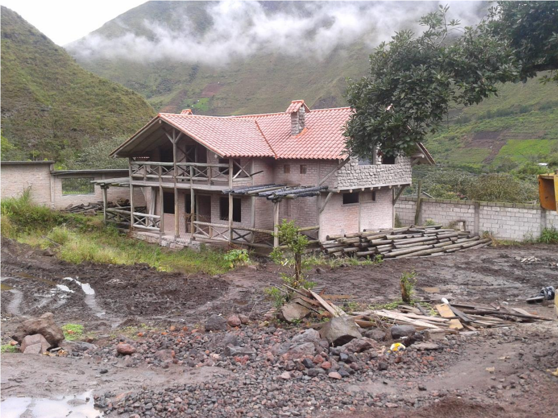
Fotografía de la locación de la construcción
