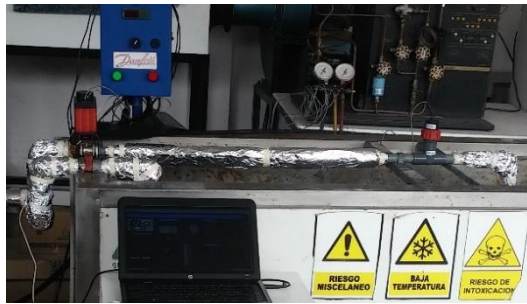
Figura 1-3: Estado final de las tuberías luego del re-aislamiento
