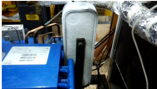
Figura 7-3: Congelamiento en el evaporador
