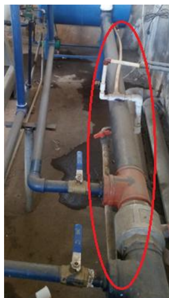
Figura 9-2. Tuberías PVC 1/2” existentes Fuente: Autor
