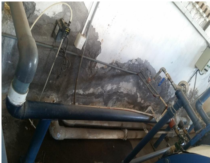
Figura7-2. Tuberías PVC 4" existentes Fuente: Autor
