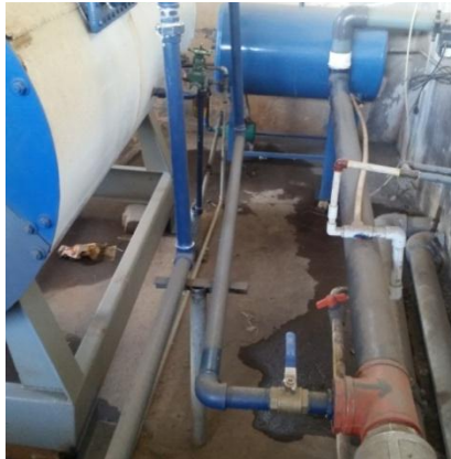
Figura 8-2. Tuberías de acero 1 1/2” existentes Fuente: Autor
