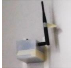
Figura 4-12 Dispositivo sensor ubicado en el laboratorio de Automatización. Fuente: Autores
