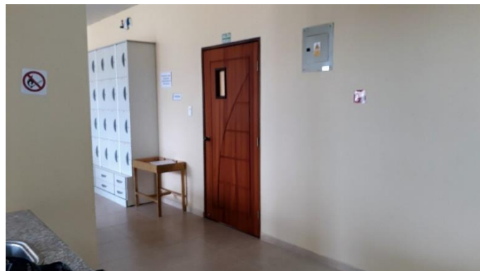
Figura 32-3: Falta de señalética vertical.
