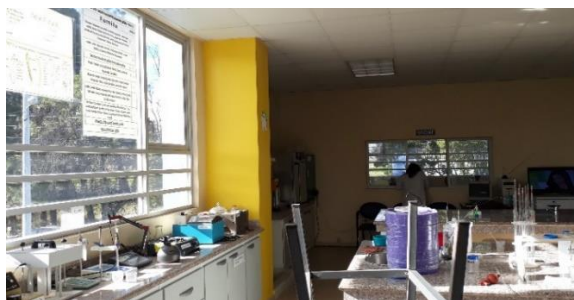
Figura 21-3: Ventana que suministra ventilación natural.
