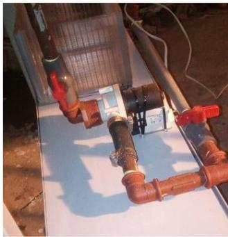
**Fotografía 23:** Instalación de la bomba para la recirculación.
