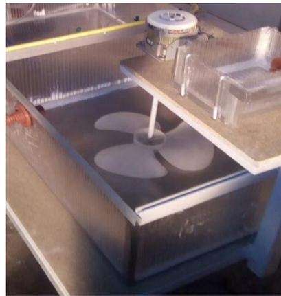
**Fotografía 20:** Instalación del agitador en el tanque equalizador
