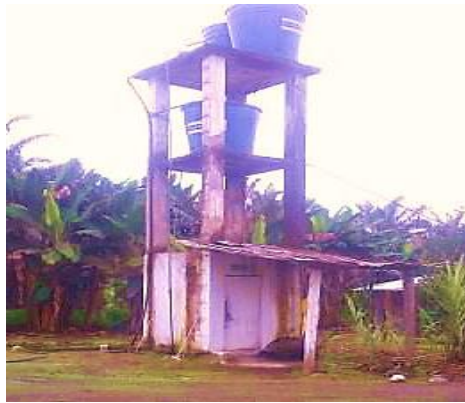
Fotografía 3-12. Tanques de almacenamiento de agua.
