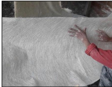
Figura 32-4. Aplicación de la fibra de vidrio
