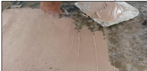
Figura 33-4. Masillado en las superficies
