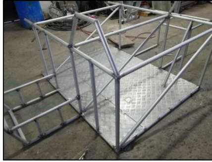
Figura 14-4. Construcción del Bastidor, Vista 3
