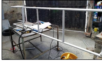
Figura 8-4. Construcción de la base
