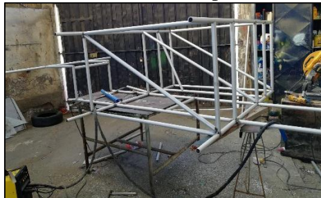
Figura 9-4. Construcción de las protecciones laterales
