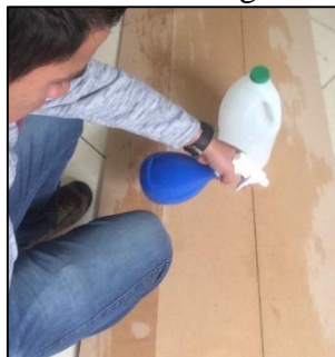
Figura 29-4. Distribución homogénea del desmoldante
