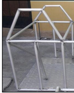
Figura 11-4. Construcción barras antivuelco
