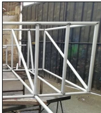
Figura 10-4. Construcción de la cabina
