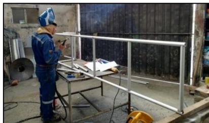
Figura 7-4. Proceso de soldadura de la base
