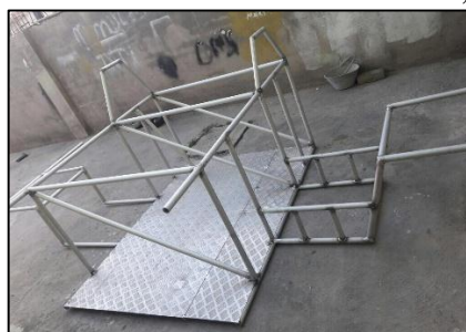
Figura 13-4. Construcción del Bastidor, Vista 2
