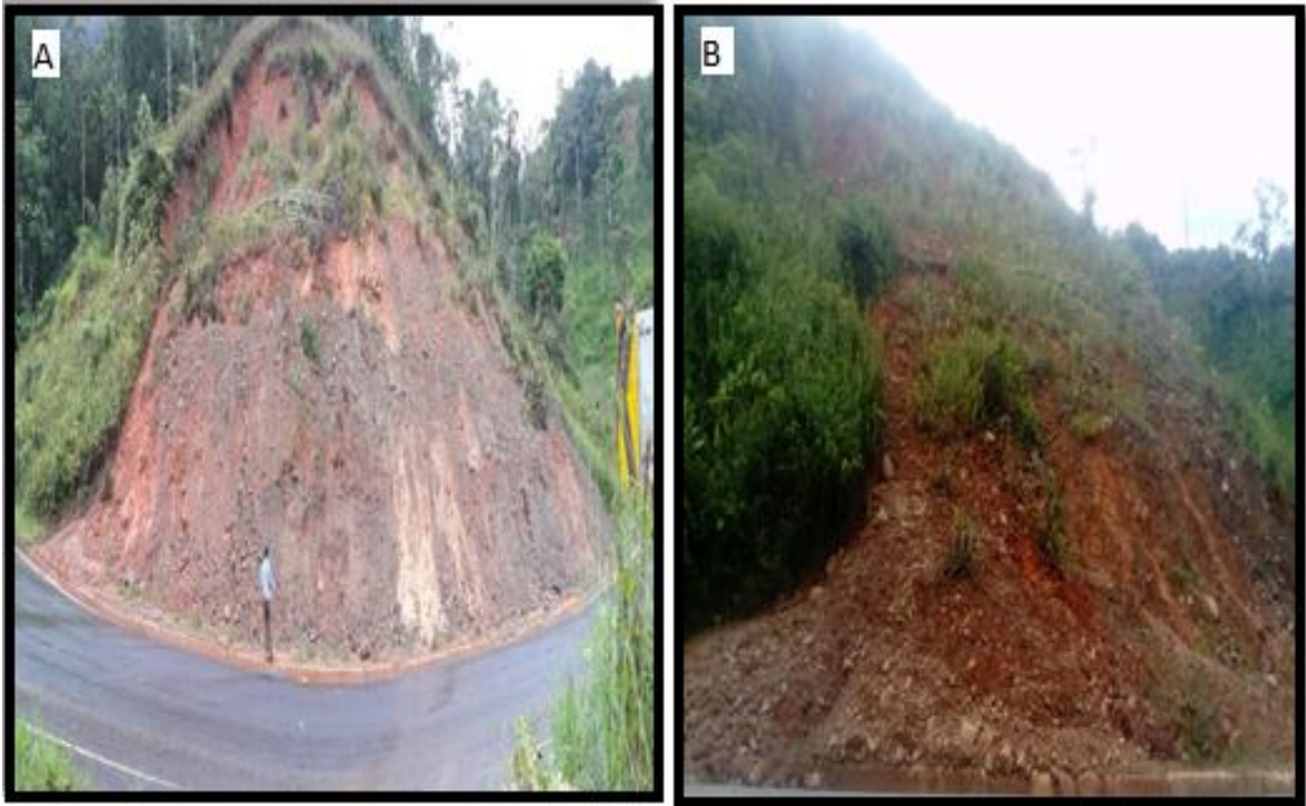
Fotografía 47-3 A) Material con mezcla de arcilla, limo, grava y arena con óxidos de hierro B) Vista lateral.
