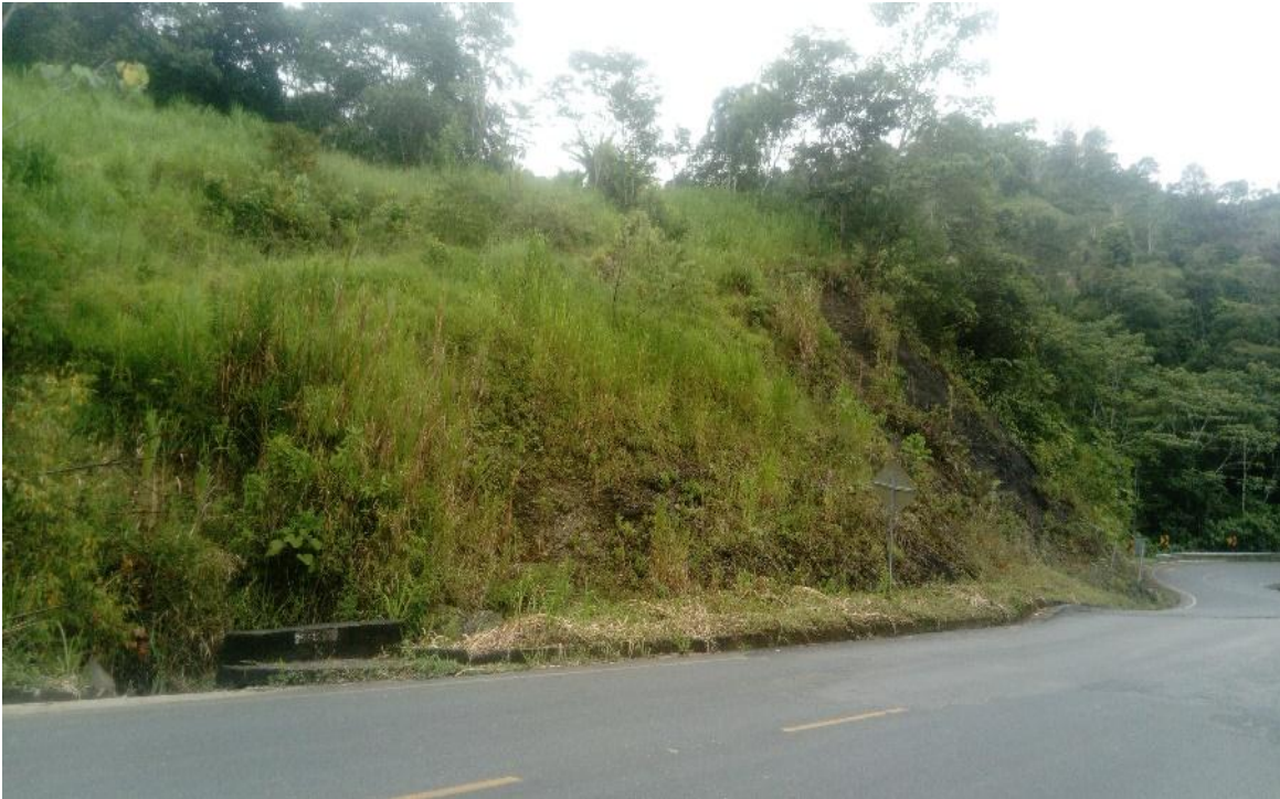
Fotografía 12-3. Contacto entre material coluvial y caliza altamente fracturada Elaborado por: Johnn Cabrera, José Solís. (2017)
