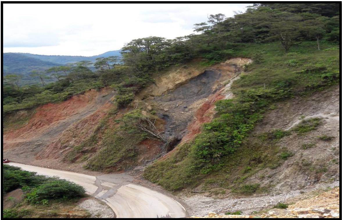
Fotografía 30-3 Se observa una gran masa desplazada y suspendida en el área del deslizamiento. Elaborado por: Johnn Cabrera, Jose Solis (2017)
