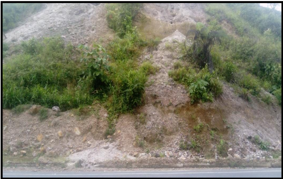
Fotografía 37-3 Deslizamiento traslacional con una mezcla de suelos y detritos con una coloración oscura.
