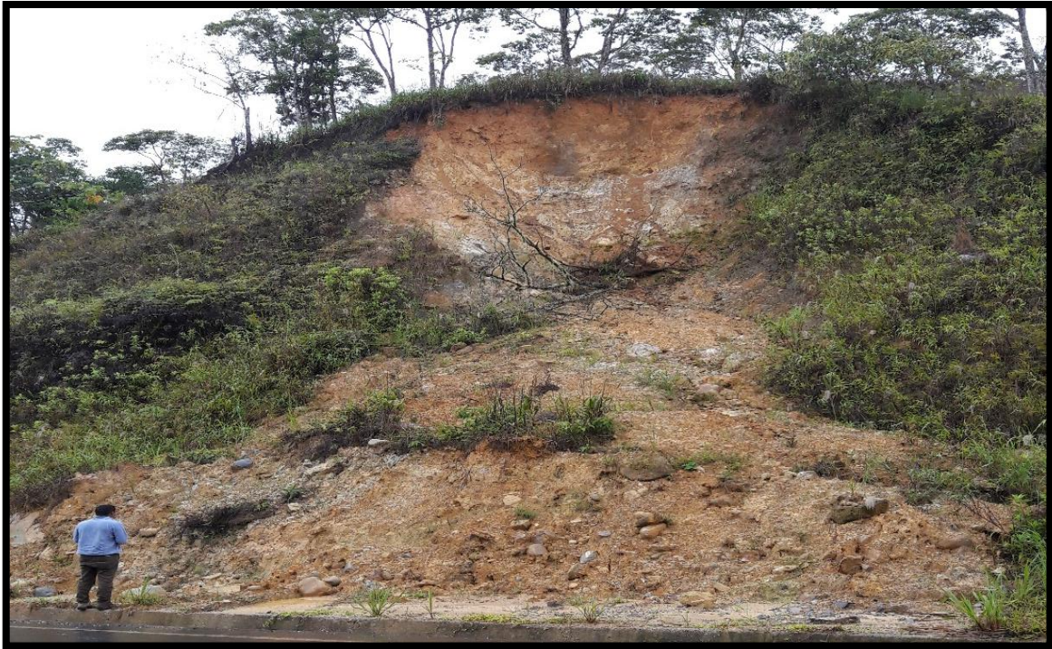
Fotografía 45-3 Deslizamiento rotacional en la parte superior está compuesto de material aluvial. Elaborado por: Johnn Cabrera, José Solís (2017)
