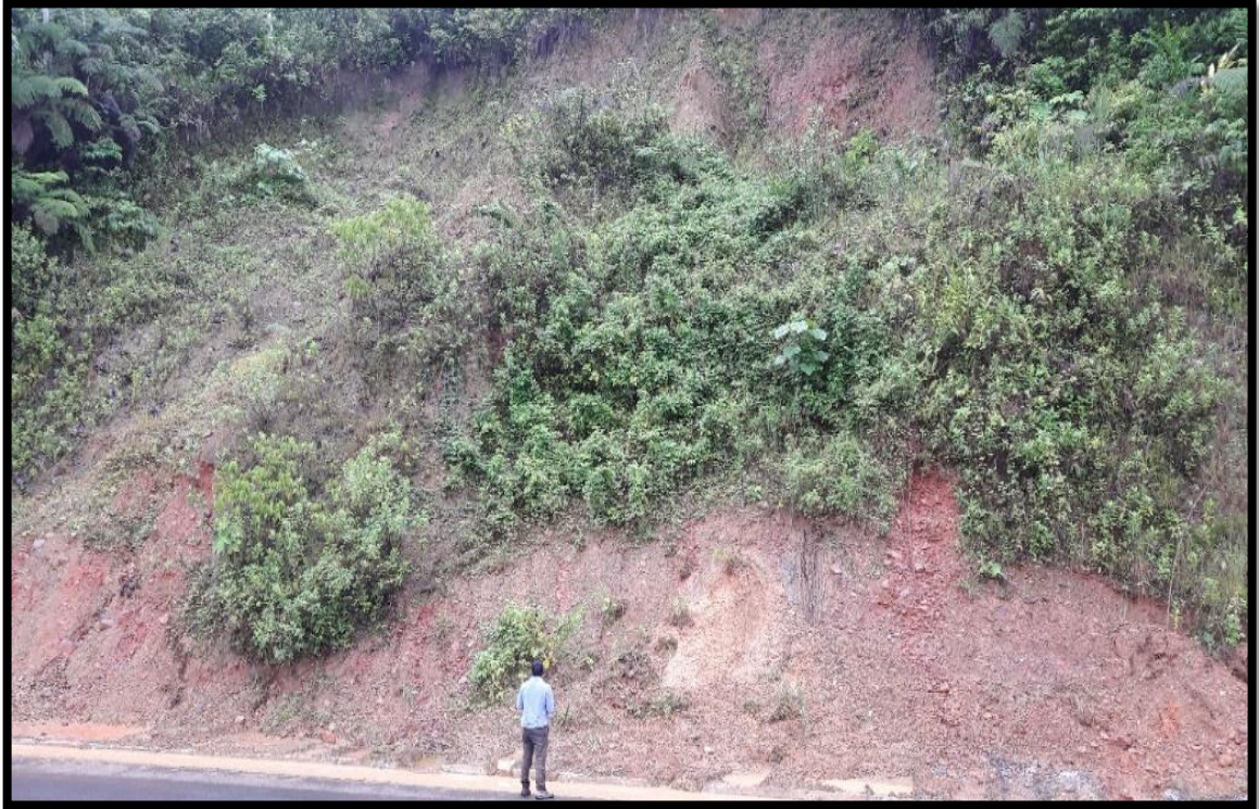
Fotografía 44-3 Deslizamiento de tipo rotacional, el material es sedimentario con una matriz areno-limosa.
