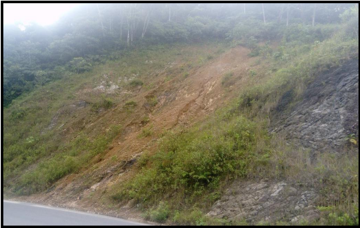
Fotografía 40-3 Deslizamiento de tipo rotacional con una mezcla de material rodado y fragmentos de calizas.
