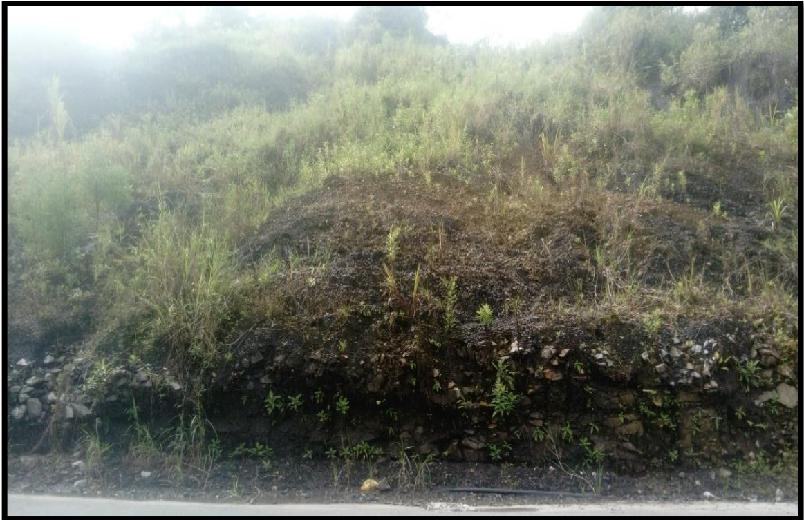
Fotografía 50-3 Deslizamiento rotacional estabilizado pero activo, desplazándose lentamente hacia la vía.
