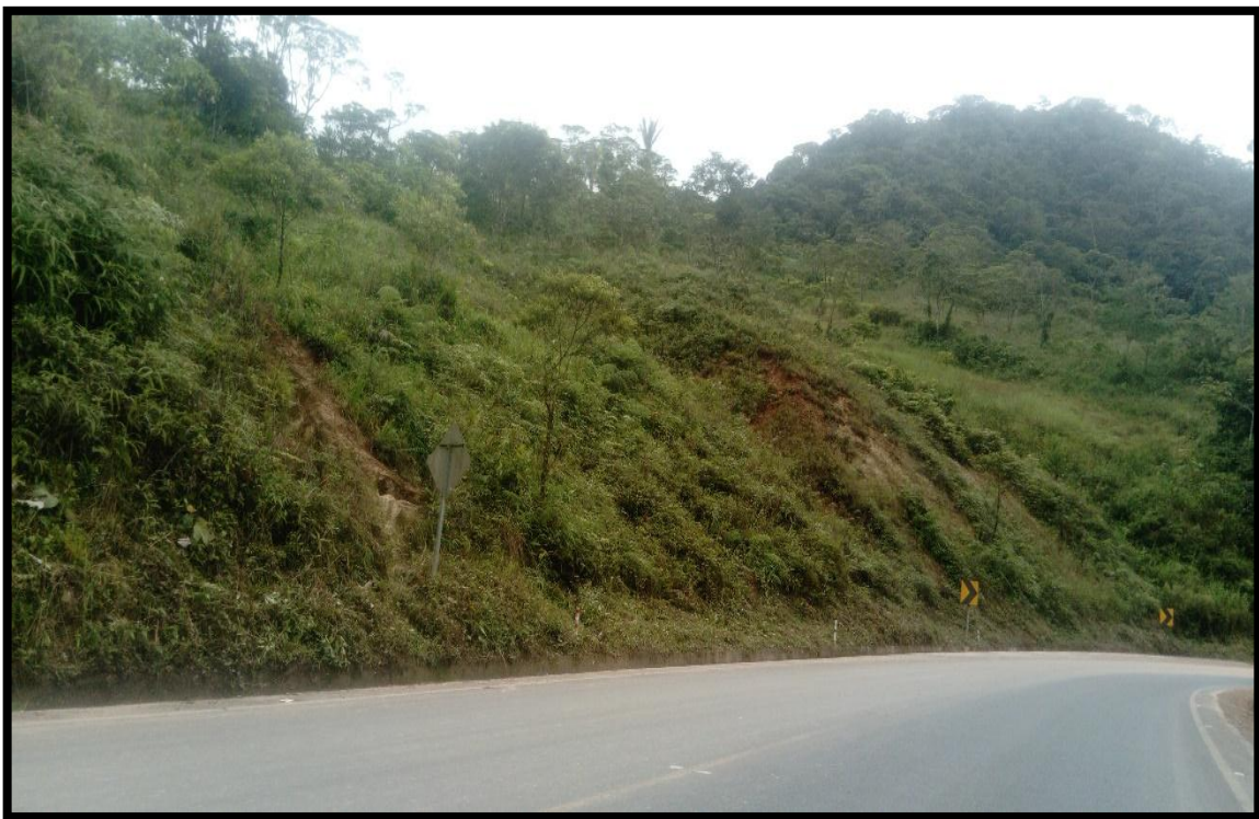
Fotografía 25-3 Movimiento no canalizado con característica del material plástico débil y material meteorizado.
