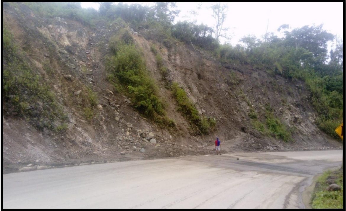
Fotografía 58-3 Flujo de escombros compuesto por fragmentos de cuarcita, arcilla y arenisca. Elaborado por: Johnn Cabrera, José Solís (2017)
