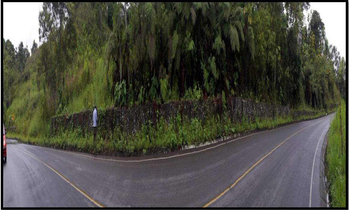
Fotografía 56-3 Deslizamiento rotacional estabilizado con muros de gaviones. Elaborado por: Johnn Cabrera, José Solís (2017)
