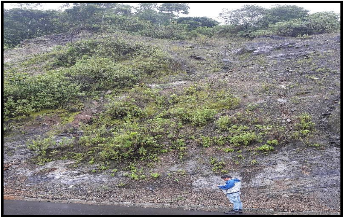
Fotografía 42-3 Flujo de escombros se aprecia calizas negras y material aluvial con óxidos de hierro.
