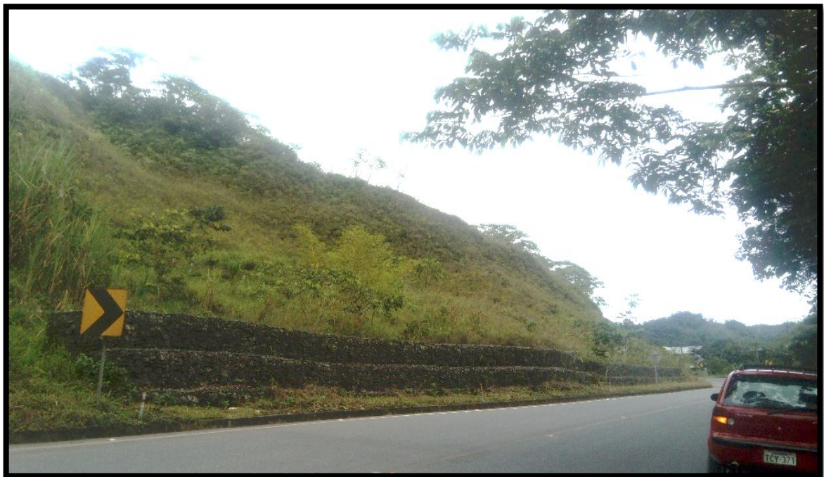
Fotografía 22-3 Deslizamiento estabilizado con muros de gaviones.
