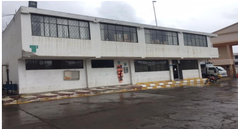
Figura 3-3. Área de oficinas del personal administrativo.
