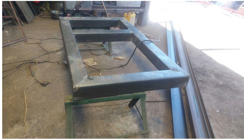
Figura 9-4. Base de la estructura con perfiles cuadrados
