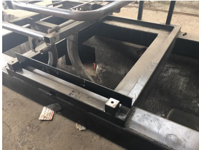
Figura 15-4. Anclaje del JIG a la estructura del banco
