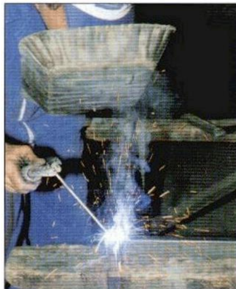
Figura 4-4. Soldador por arco eléctrico Fuente:(SENCICO, 2013)
