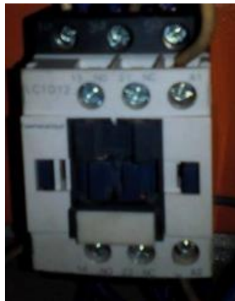
Figura 11. Contactor electromagnético LC1-D
