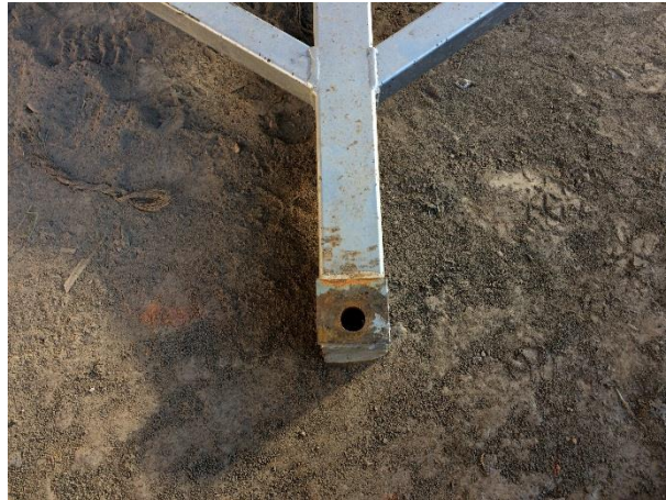
FIGURA 4-5. Placas de refuerzos en el tiro
