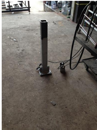
FIGURA 8-5. Construcción del acople
