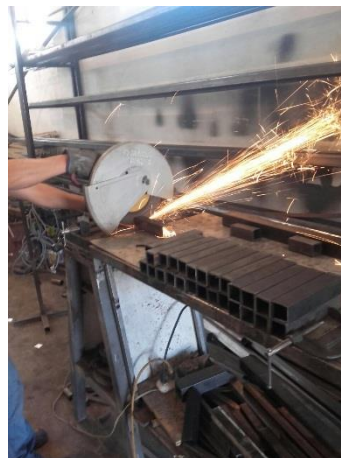
FIGURA 3-5. Corte de tubos
