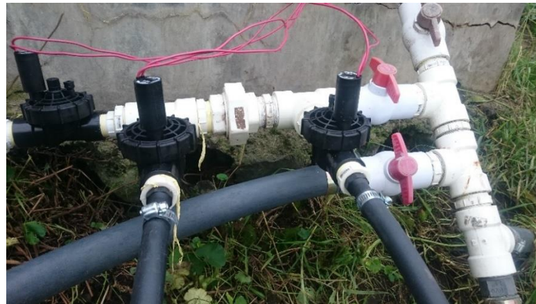
Figura 4-3: Instalación electroválvulas Realizado por: ARCOS, Daniel. 2017
