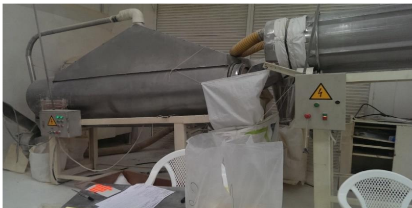
Figura N°. 66 Señales de Prevención del Área de Extrusión
