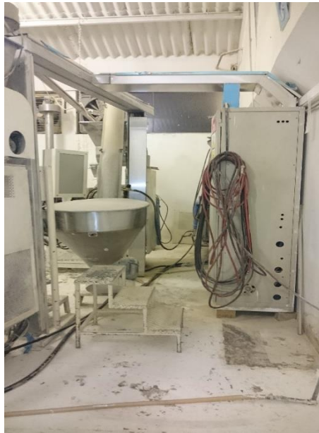
Figura N°. 40 Mejoras en el cableado eléctrico del área de extrusor
