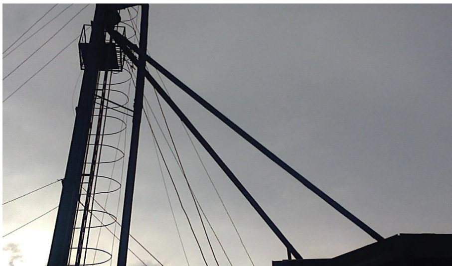
Figura N°. 4 Repartición a los silos
