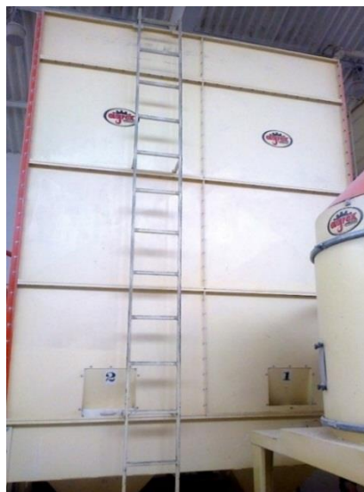
Figura N°. 8 Humectación de la materia prima
