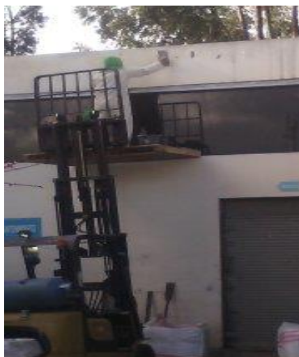
Figura N°. 31 Limpieza y Mantenimiento de Techos
