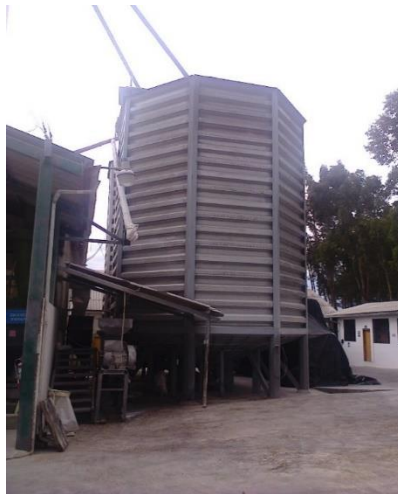
Figura N°. 30 Limpieza y Mantenimiento de Silos
