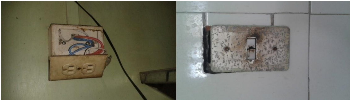
Figura 8. Toma e interruptor área de bar y cocina
