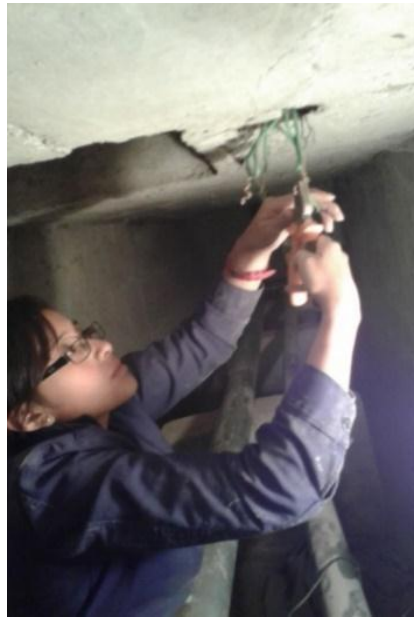
Figura 12. Iluminación túnel de ventilación
