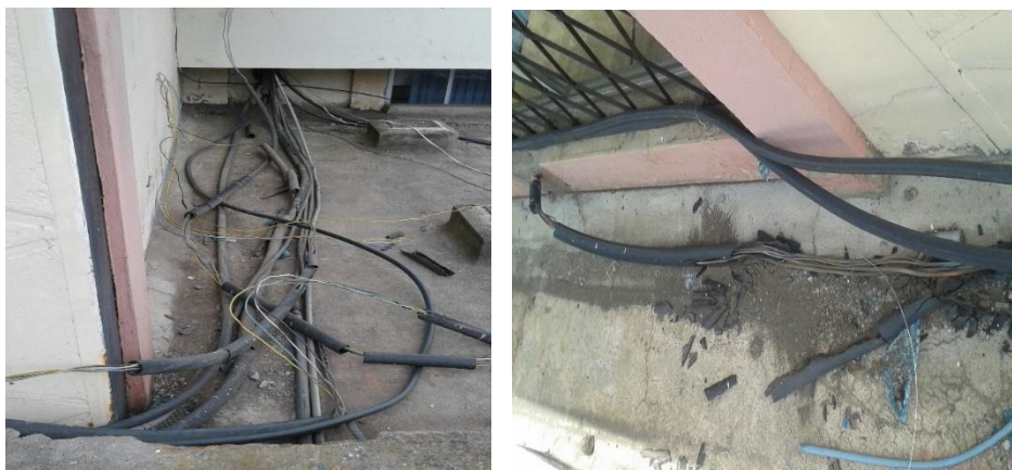
Figura 32. Terraza sala de máquinas
