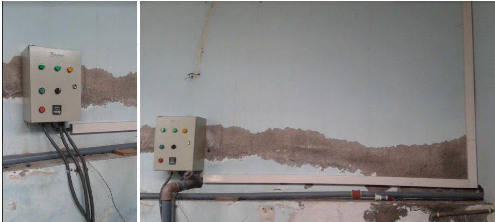
Figura 38. Hidromasaje pequeño (Aplicado mantenimiento)
