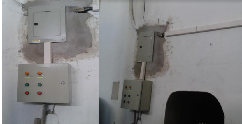
Figura 35. Alimentación tablero principal cuarto de máquinas (Aplicado
