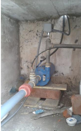
Figura 37. Bomba cisterna 1
